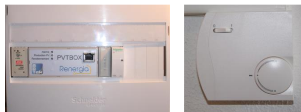
Figure 5 : Installation du régulateur dans le tableau électrique ; vue du pupitre de
