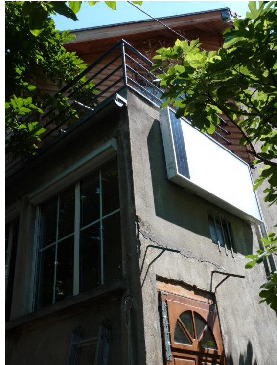
Figure 1 : Equipement placé en toiture orientée au sud : 20 m 2 de capteurs photovoltaïques et 4 m 2 de capteurs aérothermiques (modèle TOPSOLAR® de Grammer Solar)
