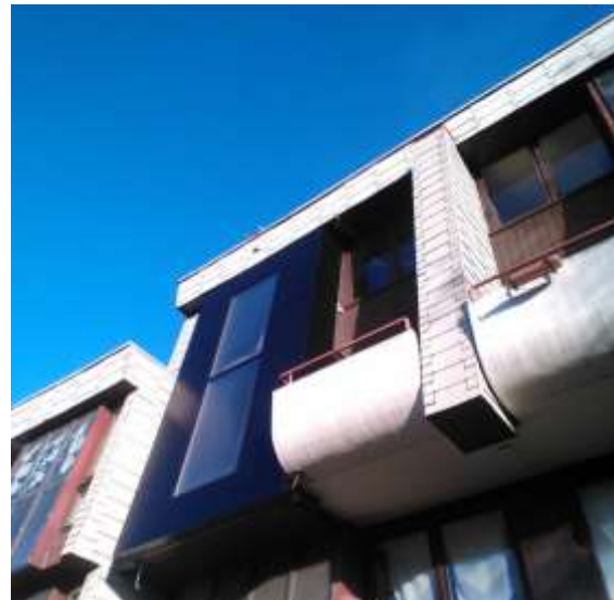
Figure 2: Equipement d'un appartement avec les nouveaux capteurs (4 m 2 , modèle TOPSOLAR® de Grammer Solar)
