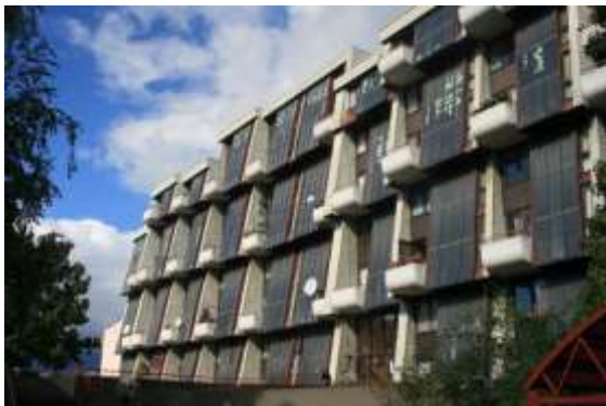
Figure 1 : vue de la façade actuelle avec les capteurs solaires
