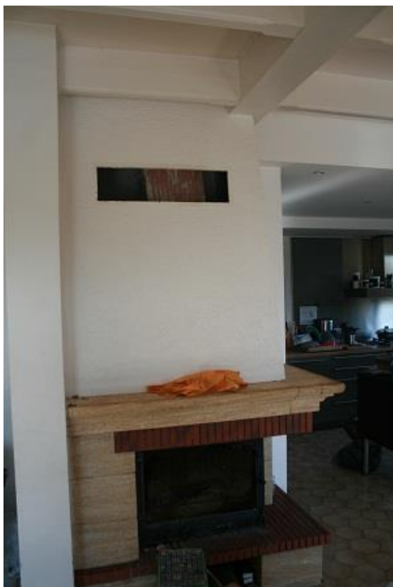
Figure 2 : Système d'insufflation de l'air chaud avant installation dans le plenum diffusant l'air du foyer bois
