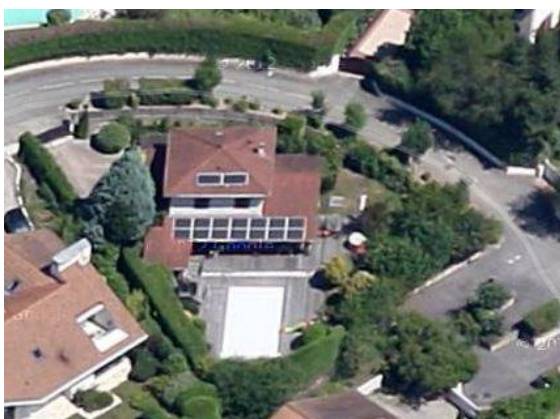
Figure 1 : Equipement placé en toiture orientée au sud : 20 m 2 de capteurs photovoltaïques et 4 m 2 de capteurs aérothermiques (modèle TOPSOLAR® de Grammer Solar)
